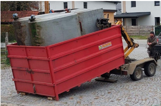
Entsorgung der alten Öltanks
